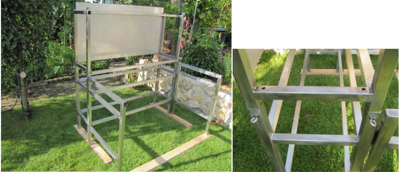
Die beiden Module mit den Rundringschrauben (M8) verriegeln.
